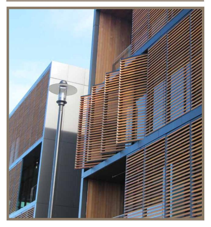
Vollay™ V4000 GLASS CASEMENT AND PANEL LIFT SYSTEMS - CASEMENT TIMBER BATTEN SYSTEM - FRAMED CTBS-FR
